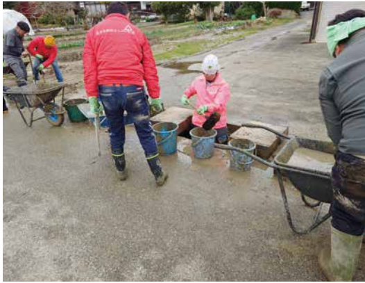
9月には記録的な大雨が降り続け豪雨災害が発生。住宅や用水路の泥のかき出しなどの支援も続いている（令和6年12月撮影）。
